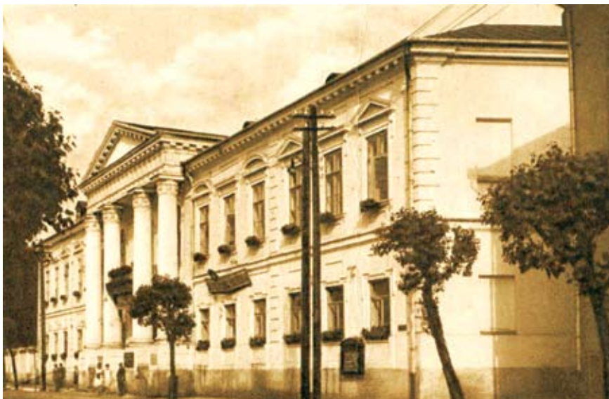
Дом віцэ-губернатора Максімовіча. Сёння адзін з будынкаў аблвыканкаму (вул. Ажэшкі).
