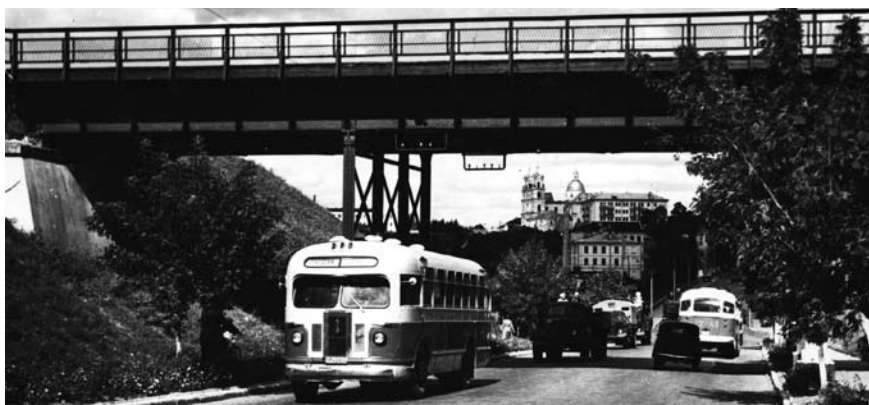
Да 70-х г. Стары мост з'яўляўся адзіным аўтамабільным злучэннем абодвух частак горада
